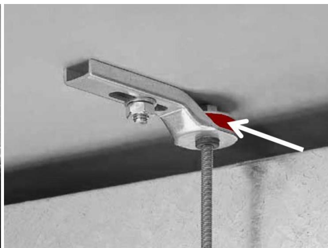
Fixation souple (tige filetée) sous gaine :
