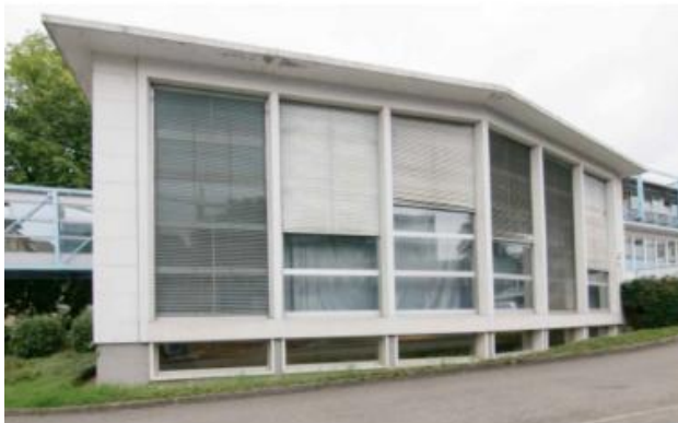
Ancienne façade ouest
