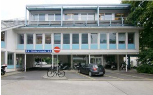
Ancienne façade, avec superstructure
